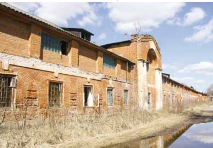
Бывшие магазины (склады) Павловской суконной фабрики
